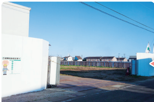
仮囲いと建設事務所ができました (2015年9月)
